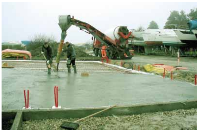
Støbningen af gulvet den 13. februar 2004.
