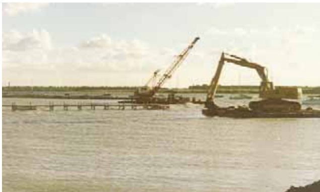
Arbejdet på havnen igangsats med oplægning af moler august 1979.
